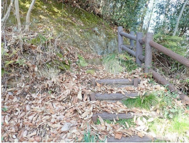
写真 劣化した遊歩道(左：劣化した階段工 右：仮修繕のままの柵工)
