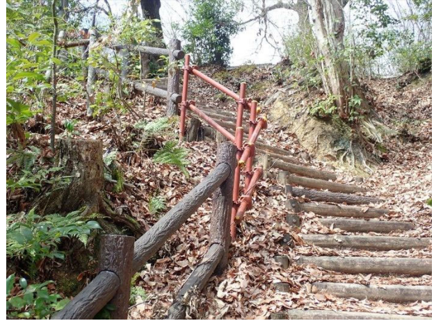
写真 劣化した遊歩道(左：劣化した階段工 右：仮修繕のままの柵工)
