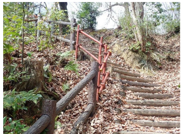
写真 仮修繕の柵工
