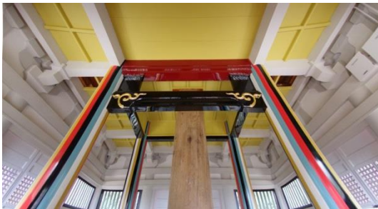
修復後 三重塔内部
