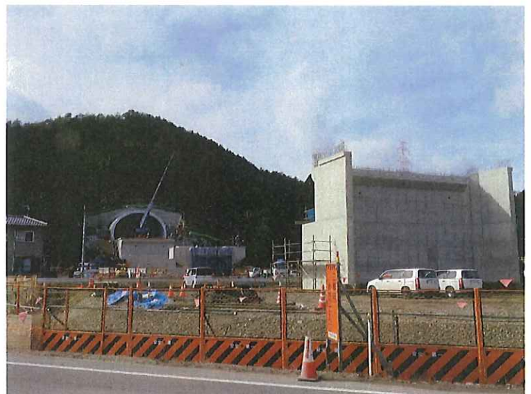
工事が進む岐阜市三輪地域
