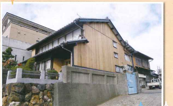
外壁をこだわりの無節の杉板を使用して改修。室外機を隠してすっきりとした外観になった。
