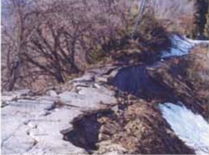
↑崩れ落ちた農道
