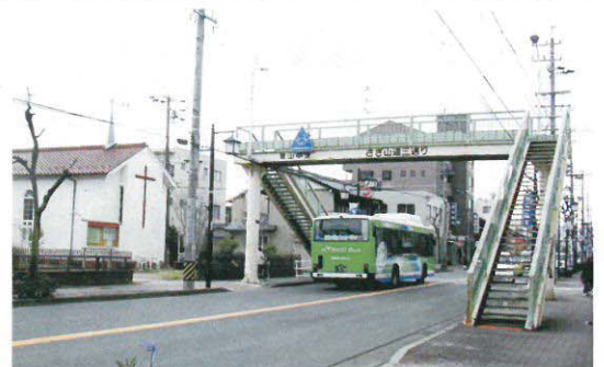
歩道橋(鷺山跨道橋)は昭和39年竣工
