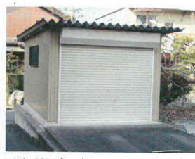
防災倉庫 3/下旬予定 (正木1512-5)
