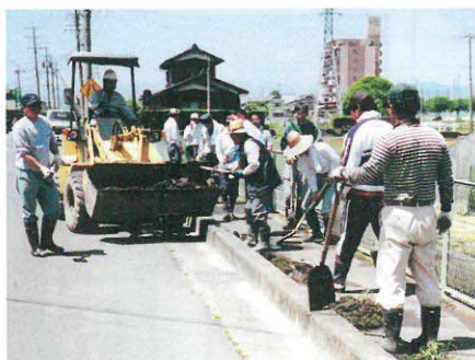
用水路の浚渫
