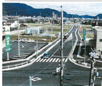
鷺山小北側～鷺山雨屋 開通
