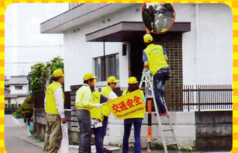
カーブミラーの点検清掃
