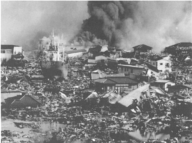
東日本大震災により、ガレキ化した民家
